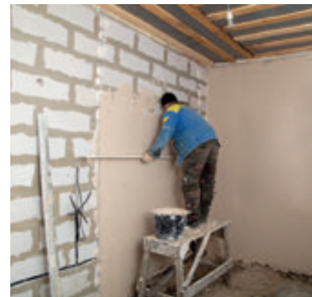
Trabajadores en construcción.
